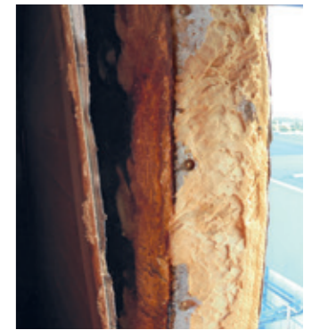
소방대가 창문을 제거하여 건물을 환기시켜 접근 할 수 있도록했습니다? 핵심 재료의 화재 침투 없음.
