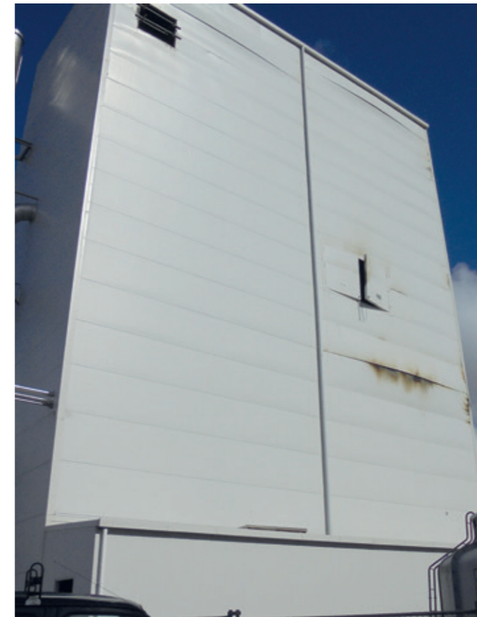
화재 후 수동으로 열린 패널 폭발 문에 외부 화재 피해를 나타내는 분유 건조 탑.
